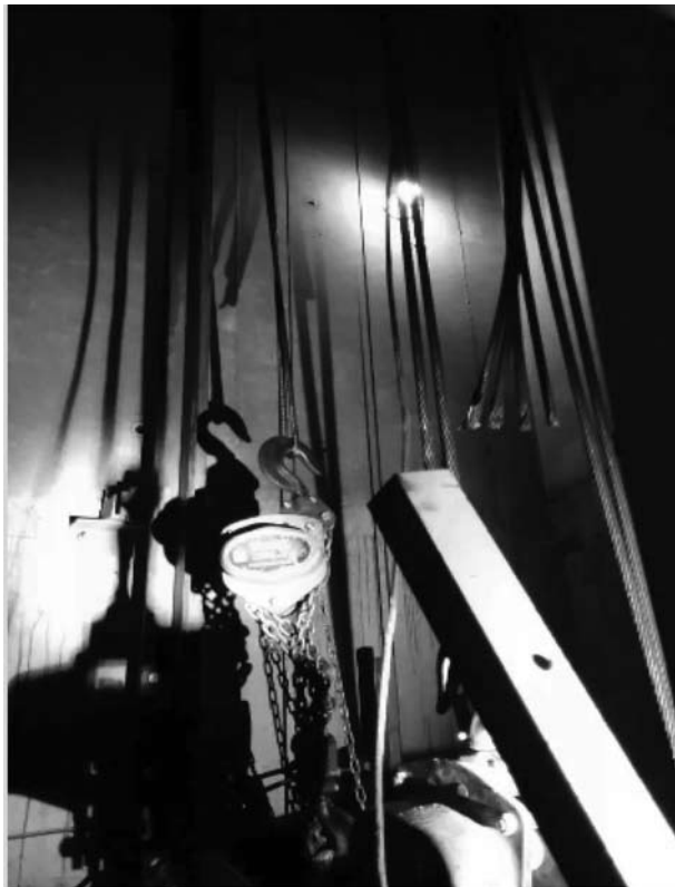
图 34 济南市“8·14”电梯挤压事故现场图片
