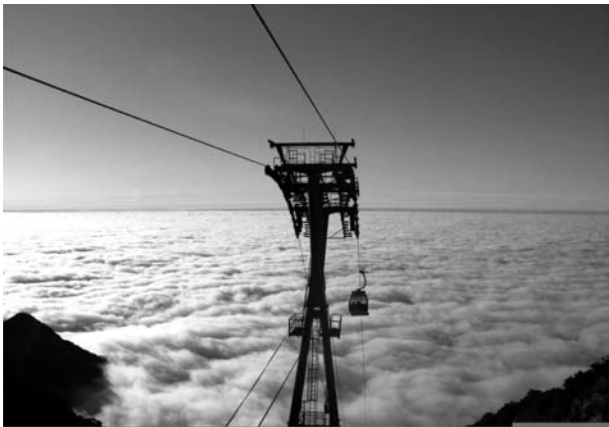
图 14 客运架空索道
