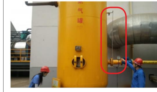
● 现场所有储气罐安全阀前有一次阀的均按照要求增加锁紧装置或悬挂禁止操作标示牌（安全阀前截止阀无锁紧装置）。
