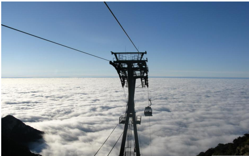
图 14：客运架空索道
