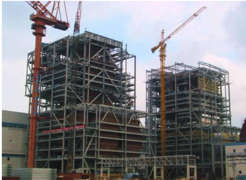
图 5：建设中的电站锅炉
