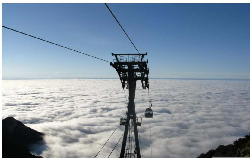
图 14：客运架空索道
